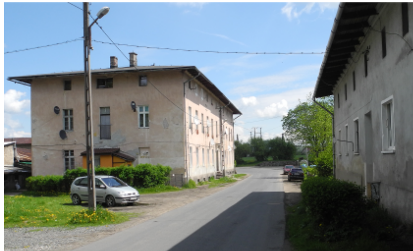
Zabudowania dawnego folwarku – widok zabudowy mieszkalnej
